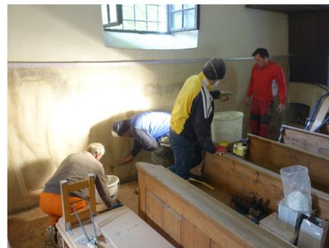
wir diese Arbeiten recht zügig für die erste Sanierungsphase fertigstellen. Die weiteren Tätigkeiten wären nun die Befüllung des 10 cm Spalts mit Kies und das Herunterschlagen des alten und beschädigten Wandverputzes. Als letzter Schritt wird die Innenwand durch eine Firma mit dementsprechendem Material schließlich neu verputzt.
